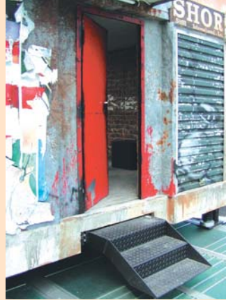
Eine der fünf ausfahrbaren Treppen des „Brickhouse“, angetrieben von Spindelhubgetrieben
