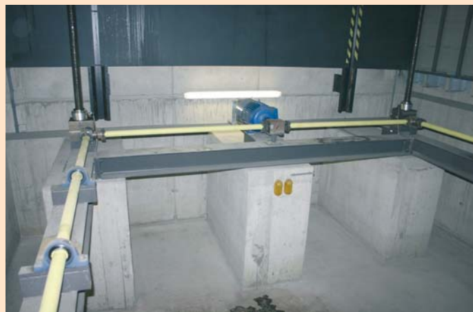
ZIMM-Hubsystem mit 4 Spindelhubgetrieben a 250 kN fur die Hub- und Senkbewegungen des 6 x 6 m groen Dekorationspodiums in der „Werkstattbuhne“
