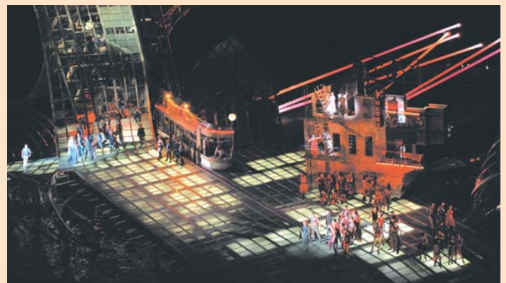
Das „Brickhouse“ (rechts im Bild) wurde durch 4 Hubsysteme gegen Windstöße abgesichert.
