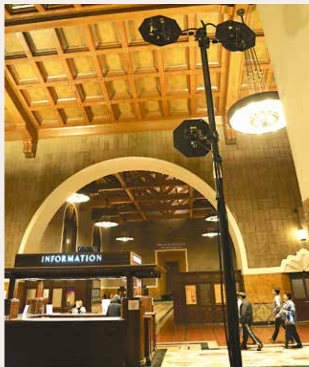
Vier Antennenzonen sorgten in der Los Angeles Union Station für eine optimale HF-Abdeckung
