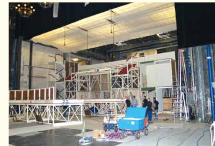
oben: Zusammenbau der Bühnenlogen-Elemente auf der Bühne unten: Einhängen der Logen-Frontabdeckungen und Montage der Leuchten: das Aussehen des Endausbaus ist bereits zu erkennen
