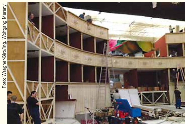
oben: Zusammenbau der Bühnenlogen-Elemente auf der Bühne unten: Einhängen der Logen-Frontabdeckungen und Montage der Leuchten: das Aussehen des Endausbaus ist bereits zu erkennen
