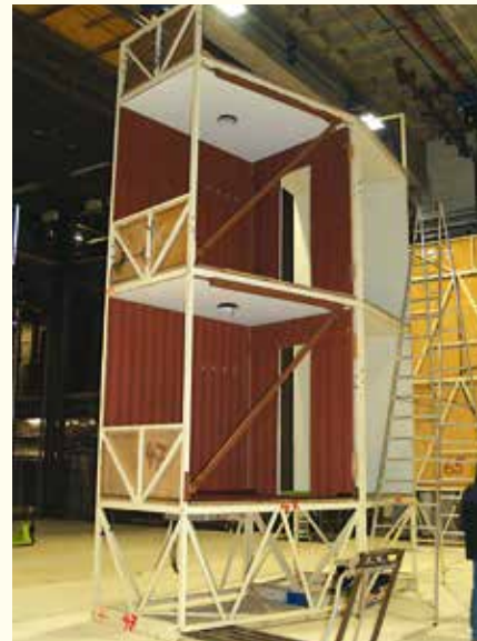
unten: Bühnenlogen- und Gang-Element, miteinander verschraubt
