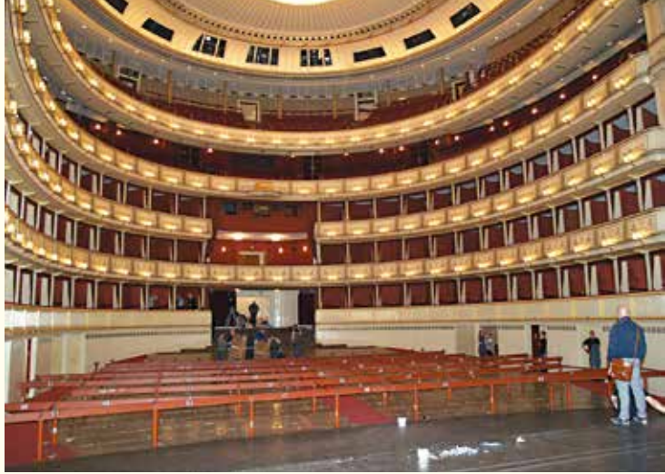
Das Tragegerüst für den Parkettboden
