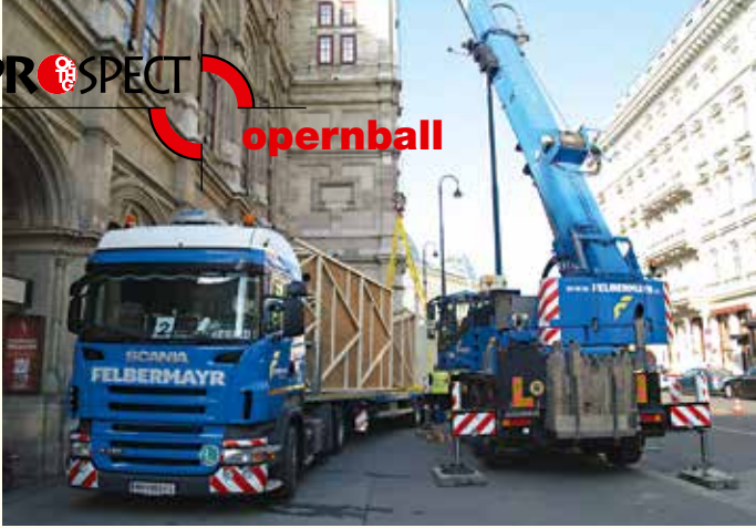
Abladen der Logen-Elemente vom Tieflader
