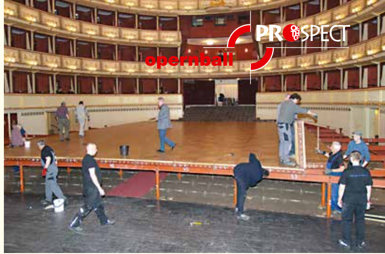
oben: Das mit den Platten belegte Gerüst
