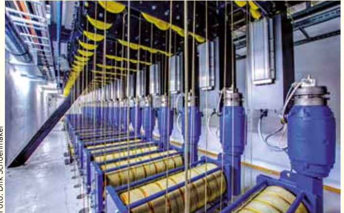
Die übersichtlich angeordneten Winden mit den Umlenkungen
