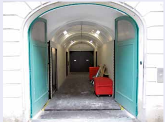
Blick von der Lehargasse auf die Hubbühne
