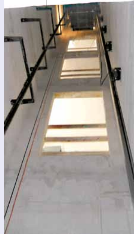
Der fertige Schacht des Personenliftes
