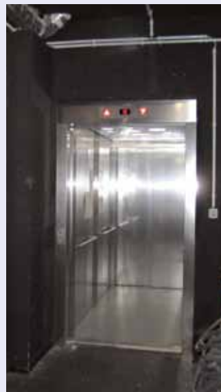
Der Personenaufzug im Bereich der Hinterbühne
