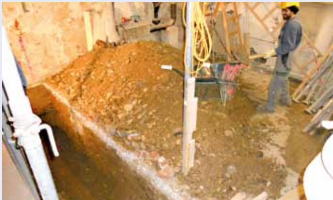
Die Grabarbeiten für Hubbühne und Aufzugschacht mussten manuell durchgeführt werden
