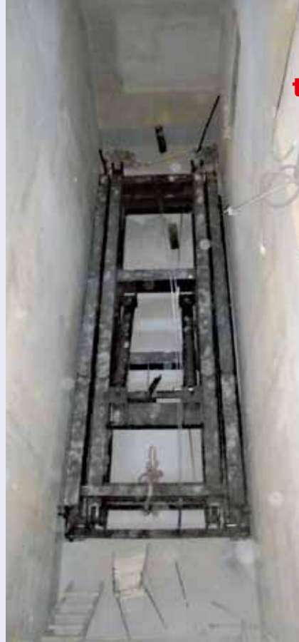
Der fertige Schacht der Hubbühne bereits mit der Schere des Antriebes
