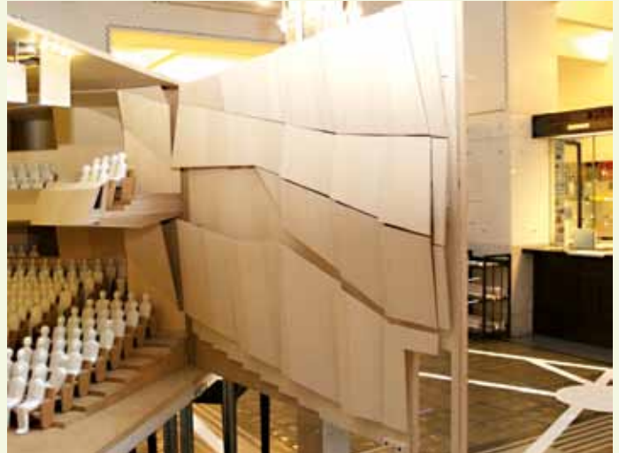
Die aufklappbare Seitenwand mit den verstellbaren Wandpaneelen
