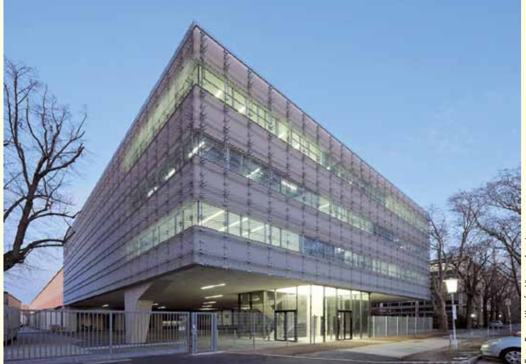
Die schwebende Probebühne mit dem sehr ansprechenden Eingangsbereich
