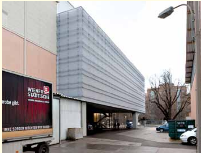
oben: Die mit Gittern aus Streckmetall umhüllte Fassade rechts: Detail der Fassade unten: Foyer mit Stiegenhaus
