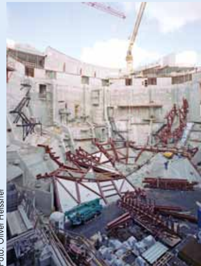
Einbringen der Stahlkonstruktion für die Zuschauertribünen
