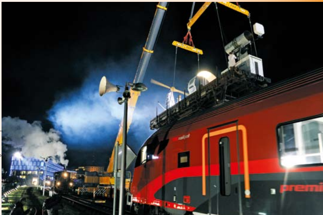
500 Meter Schienen wurden entlang der Donau verlegt: für den Railjet, die Dampflokomotive und die Draisine
