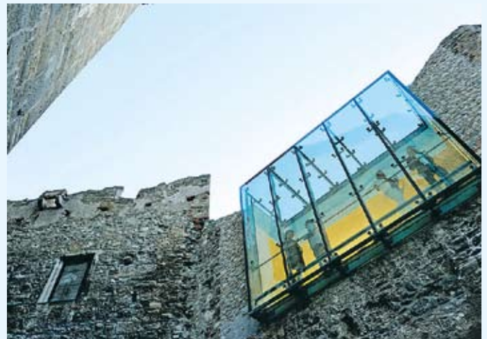
Die auskragende Glaswand des Foyer
