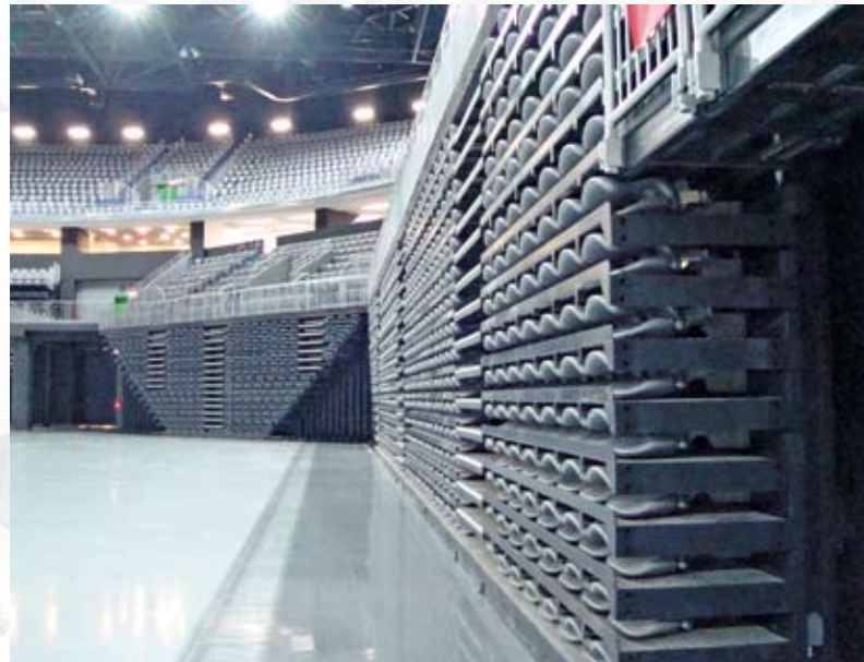
Bild oben und unten: Die Teleskoptribünen in der äußerst platzsparenden, zusammengeschobenen Position
