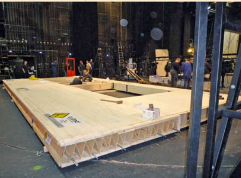
oben: Die in Bau befindliche Drehwand: Sie ist in einer vorgespannten Holz-Kielsteg-Bauweise gefertigt
