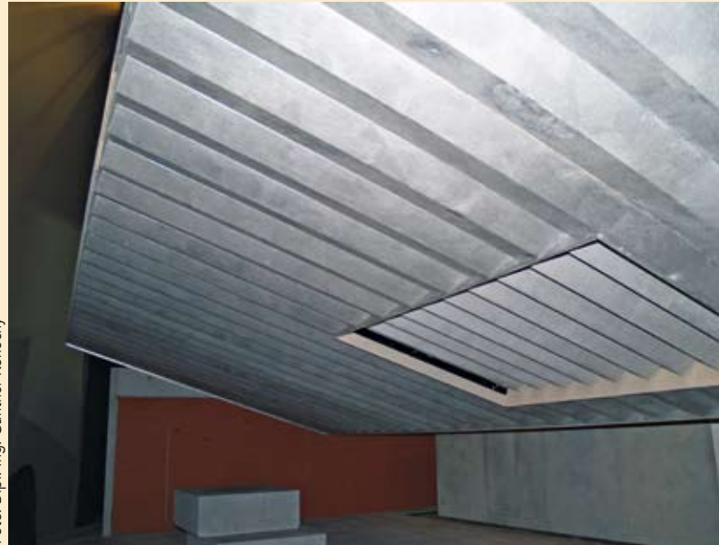
Bild oben und unten: Die Drehwand mit herausklappbarer Treppe
