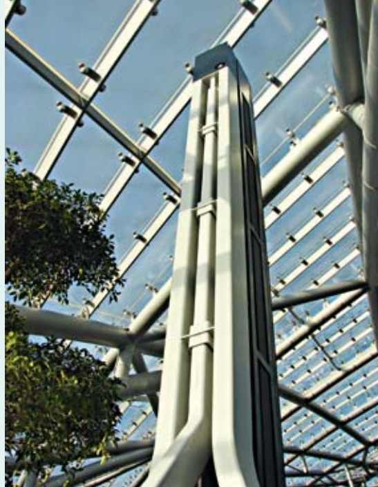
Rückansichten müssen nicht immer unansehnlich sein. Auch die Rückseite entspricht dem Design.
