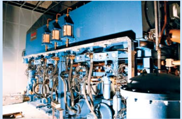
Die Hydraulikstation kurz vor dem Abschluss der Montagearbeiten
