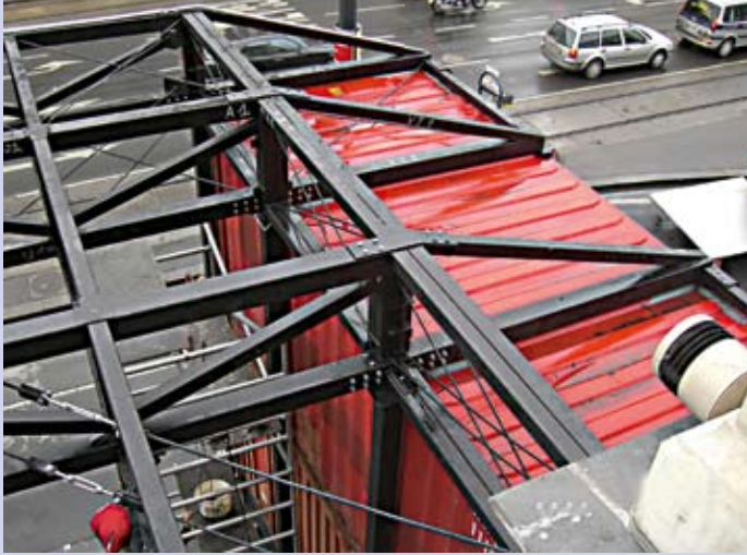
Mit den Containern verschraubte Dachkonstruktion
