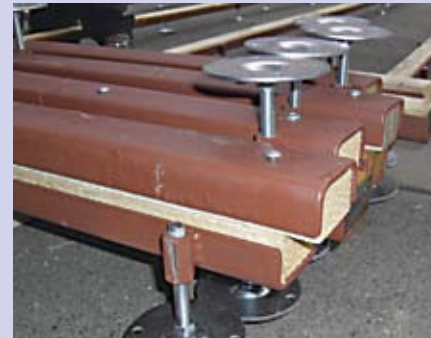
Detailansicht der höhenverstellbaren U-Profile mit eingelegten Vierkant-Holzlaten
