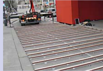
Auslegen der Fahrbahn mit den höhenverstellbaren Stahlprofilen
