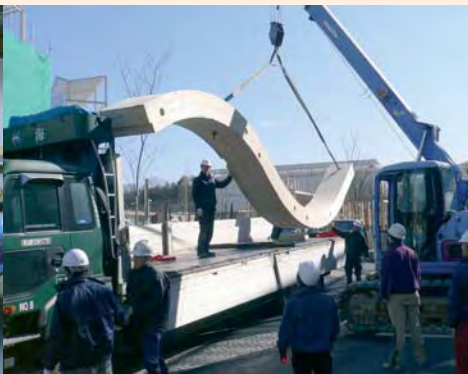
Abladen der riesigen Holzteile
