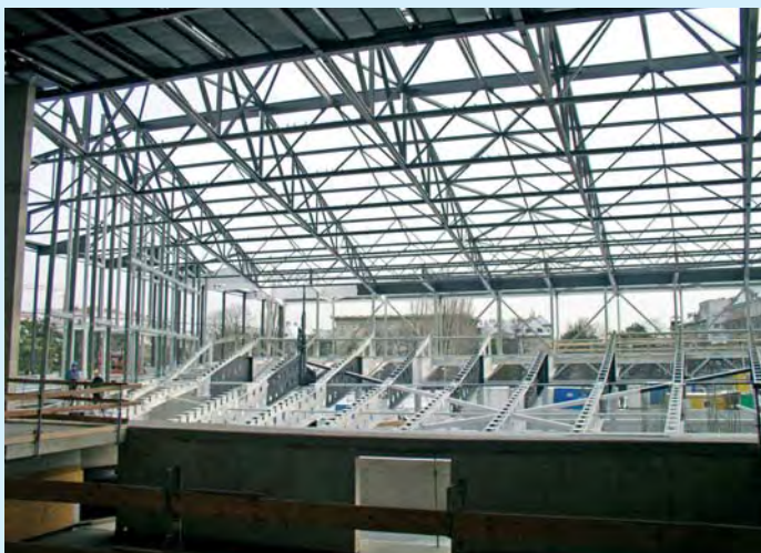
Blick von der Bühne auf die Stahlkonstruktion des Zuschauerraumes
